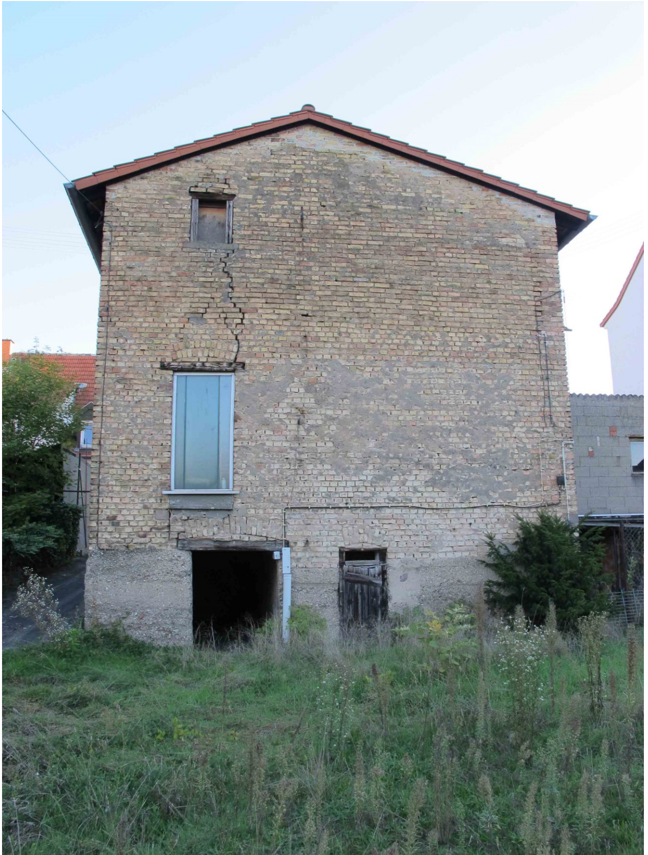
Bild 1: Gebäude an der Nordwest-Seite des UGs. Die Spalten und Zugänge des Gebäudes könnten planungsrelevanten Fledermausarten potentiell als Quartiere dienen.
